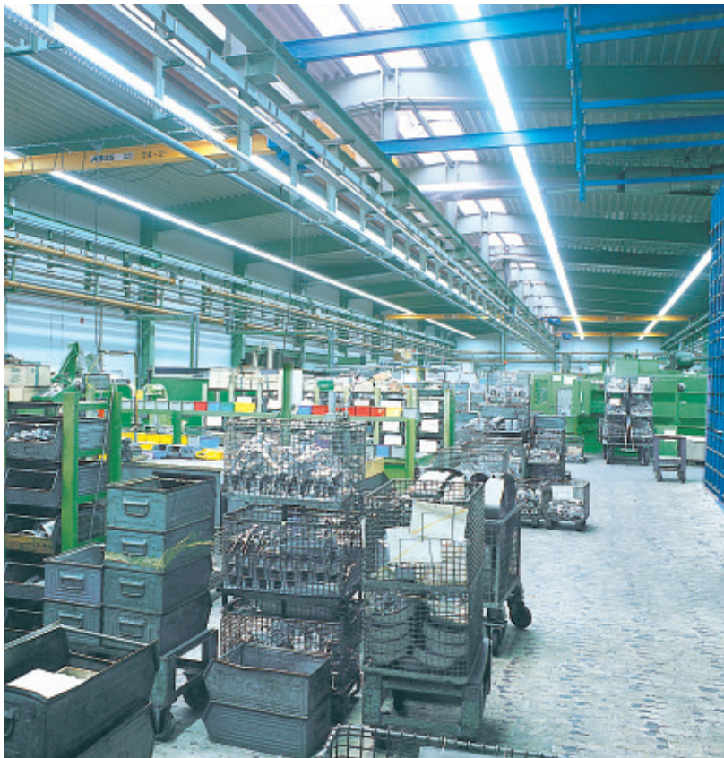
(Bild 7) Auch in der Produktion: Beleuchtungsqualität mit Dreiband-Leuchtstofflampen an EVG
