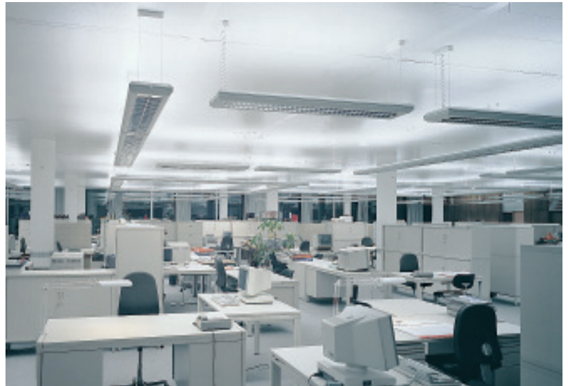
(Bild 6) Sehkomfort: Wirtschaftliches Licht von Dreibanden-Leuchtstofflampen an EVG
